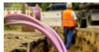
12 till 14 bar: Kabelbläsning och borring
